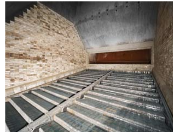
FEUERRAUM mit Vorschubrost COMBUSTION CHAMBER with forward-acting reciprocating grate
