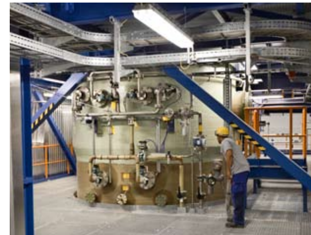
Eindüsung von Kalkmilch in den ZWEITEN WÄSCHER Injection of lime milk into the SECOND WET SCRUBBER
