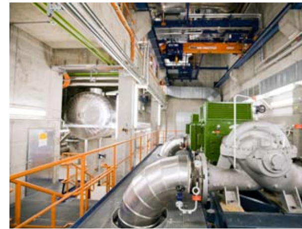
FERNWÄRMEPUMPEN DISTRICT HEATING PUMPS
