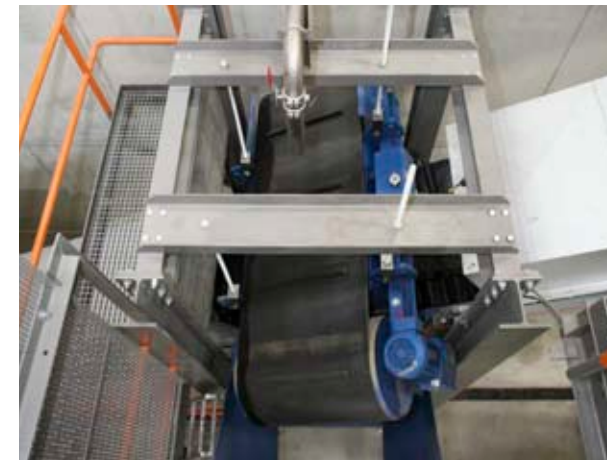
Ein MAGNETABSCHIEDER separiert die Eisen-Metalle aus dem Abfall A MAGNETIC SEPARATOR separates the ferrous metals from the waste
