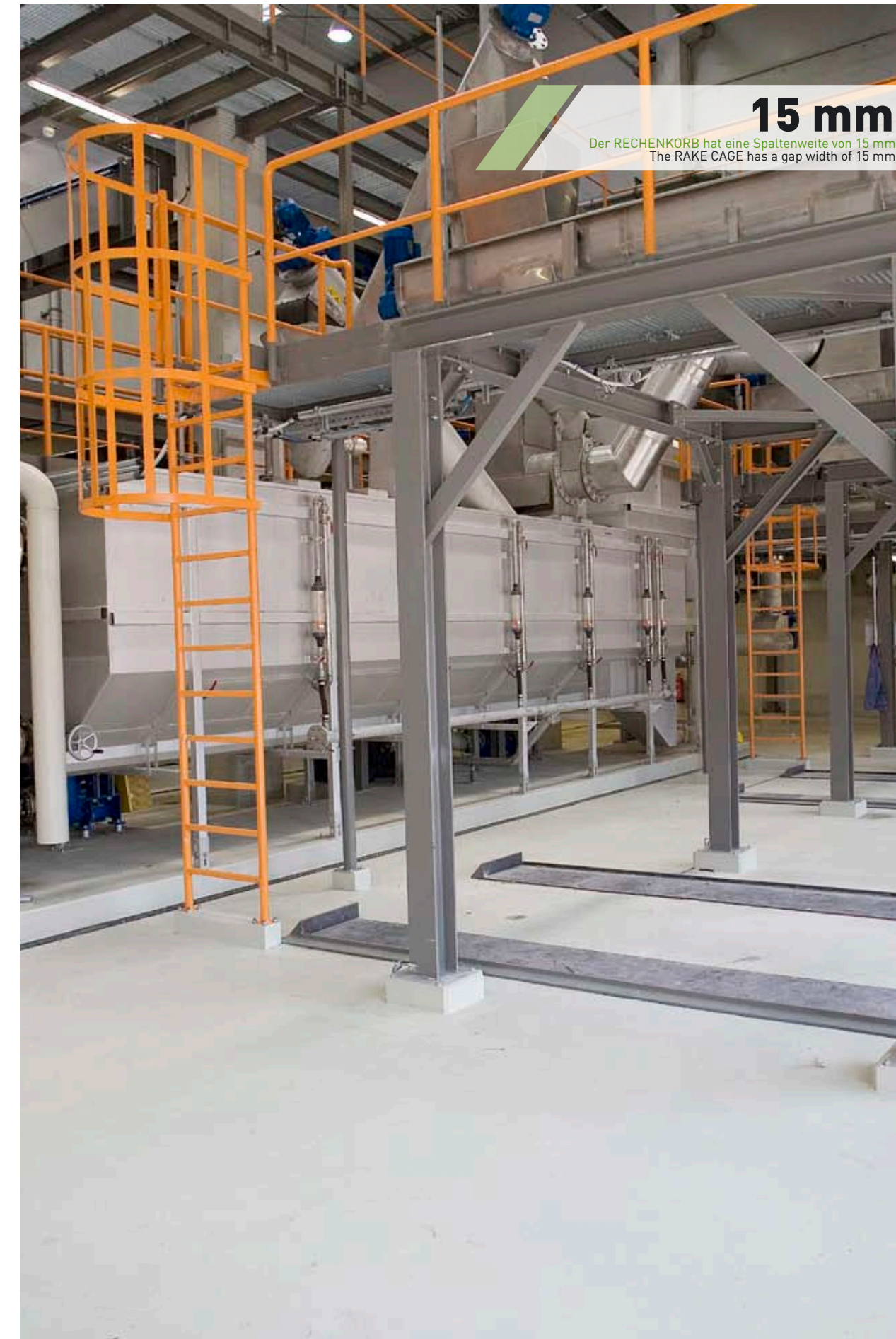
RECHENKORB mit umlaufender Harke RAKE CAGE with a revolving rake
